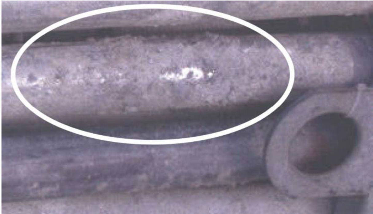
Afbeelding 11: ontoelaatbaar grote stukken betonrest en deuken in de buitenbuis
