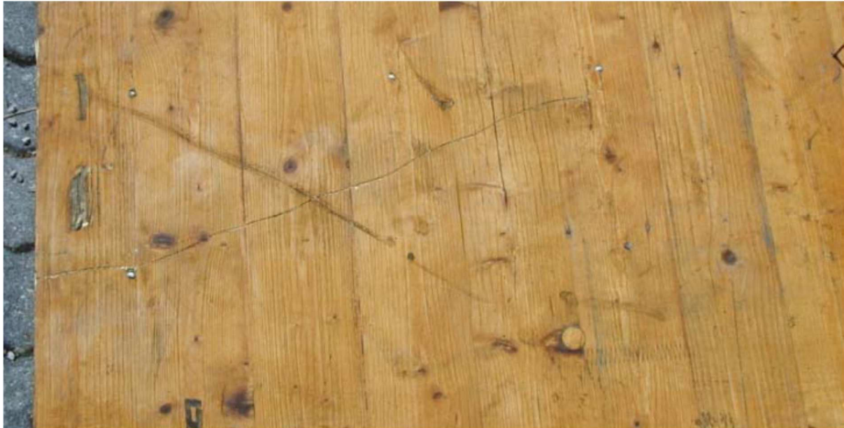
Afbeelding 4: toelaatbare beschadiging van oppervlak
