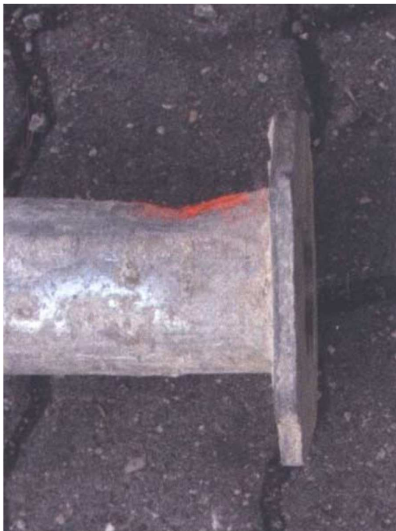
Afbeelding 12: ontoelaatbaar grote stukken betonrest en deuken in de buitenbuis
